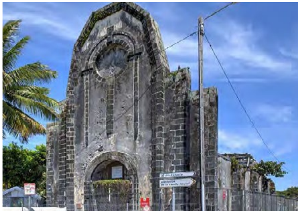
Chapelle Sainte-Jeanne d'Arc à Saint-André © Fondation du patrimoine - MyPhotoAgency-C. Bersano
